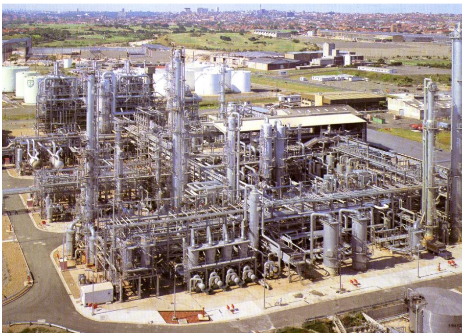
Рис. 8.1. Этиленовая установка производительностью 250 000 тонн в год
